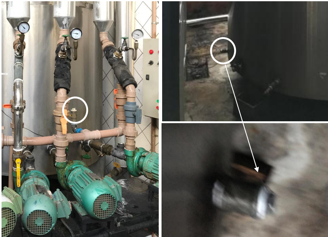
Figura 32. Detalhes de vedações aparentemente recentes na saída do tanque de glicol (C2) e de uma saída do tanque de água gelada (este último também detalhado na Erro! Fonte de referência não encontrada.27).
