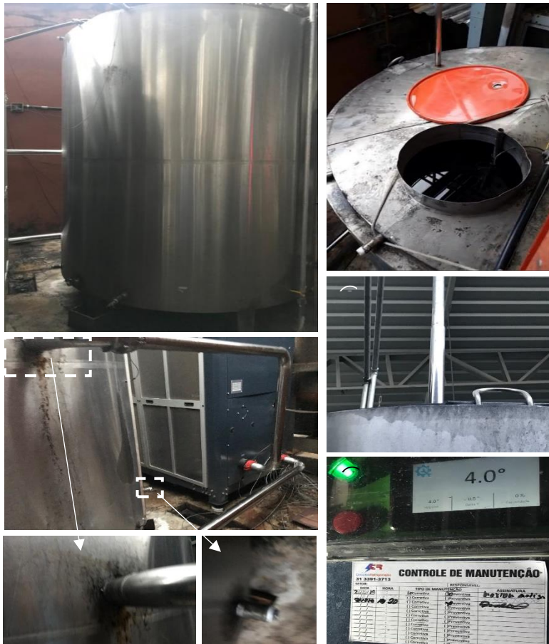
Figura 27. Tanque de água gelada que serve à brassagem, no resfriamento do mosto (segundo estágio). Detalhes parciais: 1) corpo; 2) abertura e tampa solta no topo do tanque; 3) tubo de inox de entrada de água; 4) painel eletrônico do chiller “C3”, tendo afixada ao equipamento uma ficha de controle de manutenção; 5) detalhe de uma abertura inferior tampada; 6) marcas de escória de soldagem na fixação da tubulação que liga o tanque ao chiller.
