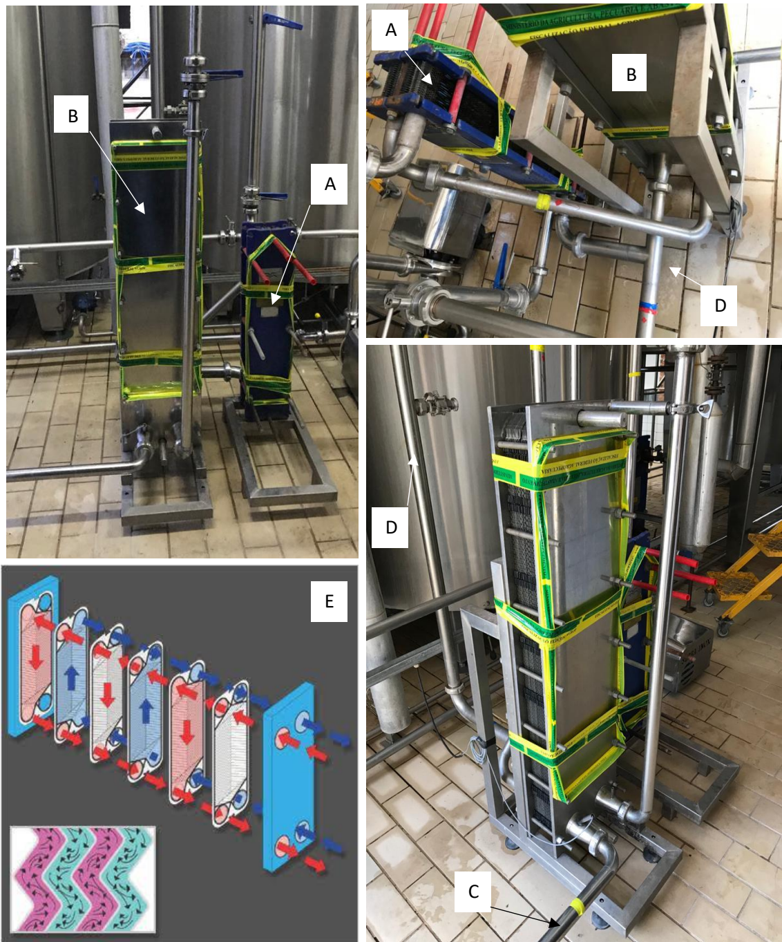
Figura 28. Trocadores de calor para resfriamento do mosto, de duplo estágio, o menor (A) realiza a primeira troca térmica entre a água ambiente e o mosto quente, o qual perde calor e passa para o segundo trocador (B), que faz a troca com água gelada, gerando mosto à temperatura adequada que segue (C) para o fermentador (entre 12 e 18°C, dependendo do tipo de cerveja). As águas de ambos estágios absorvem o calor transferido do mosto e são conectadas numa única tubulação (D) que segue para a tina auxiliar. A troca de calor ocorre entre os líquidos no interior das placas, montadas intercaladas e vedadas por gaxetas (E).
